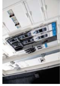
ersN-HS_patroonlastscheider
